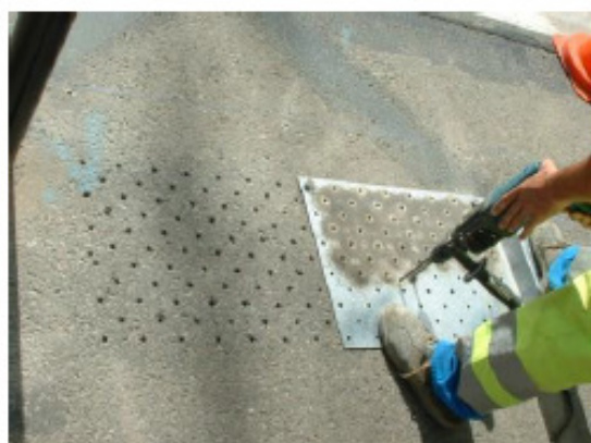
Perçage des trous et élimination des poussières
