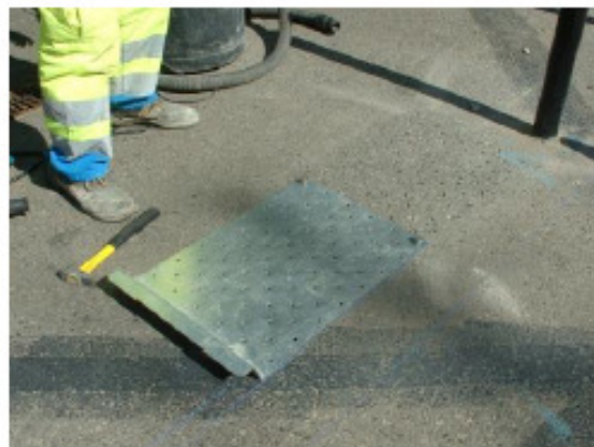
Placement du gabarit et des plots de positionnement
