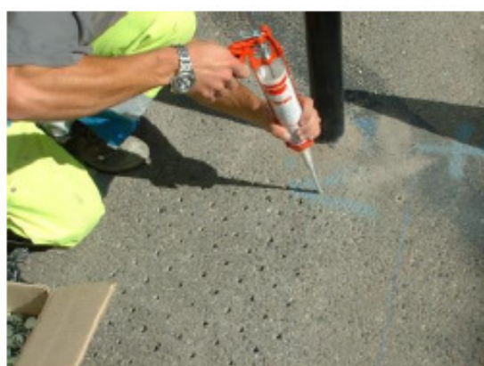
Remplissage avec scellement chimique et insertion des clous
