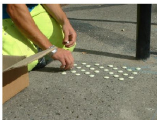
Remplissage avec scellement chimique et insertion des clous
