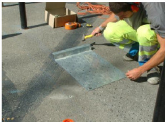
Placement du gabarit et des plots de positionnement
